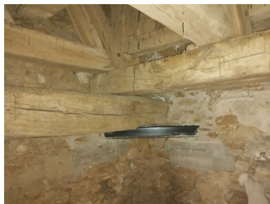
Renfort des poutres
