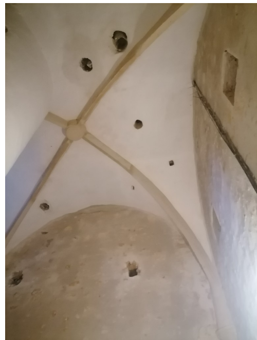
Rénovation des voûtes
