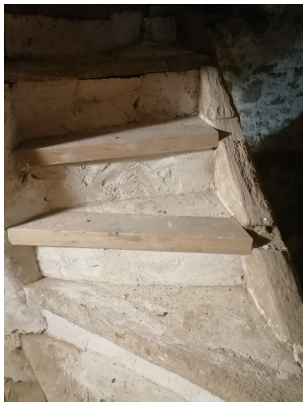
Réfection de l'escalier
